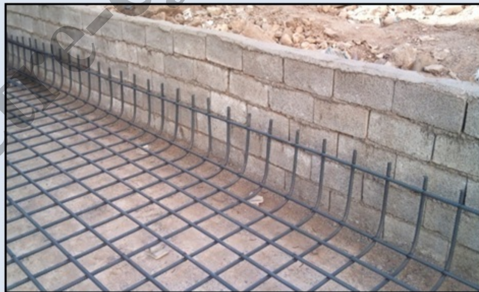
آرماتورهای تحتانی فونداسیون
